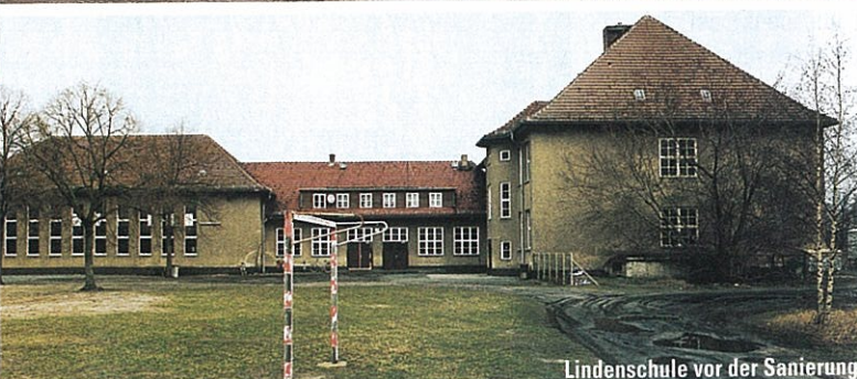
Lindenschule vor der Sanierung
