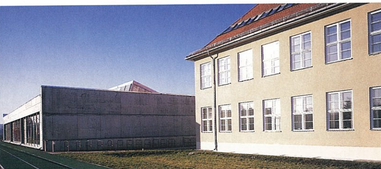
Restauratorische Maßnahmen am Bestand: Aufarbeiten der Holzfenster, neues Aufbringen des historischen Sandkratzputzes nach originaler Rezeptur und eine komplett neue Dachdeckung, ebenfalls nach historischem Vorbild
