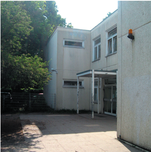
Blick zum Eingang vor dem Umbau
