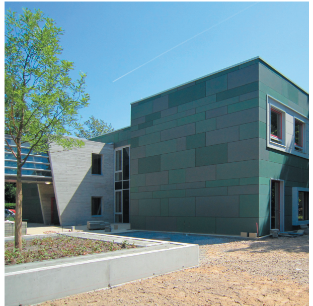
Blick zum Eingang nach dem Umbau mit Verbindungsbrücke zum Treppenhausneubau und zum Bestand
