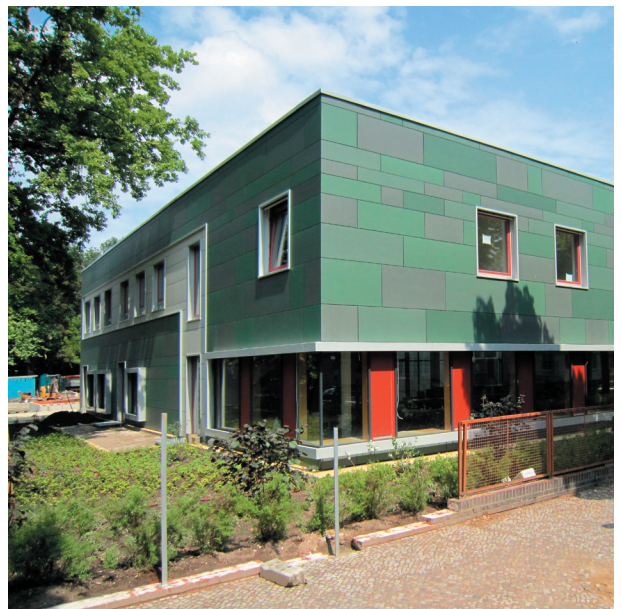
Blick Westfassade Hof nach dem Umbau mit Blick auf das Mensafenster
