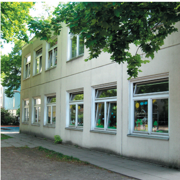
Blick Westfassade Hof vor dem Umbau
